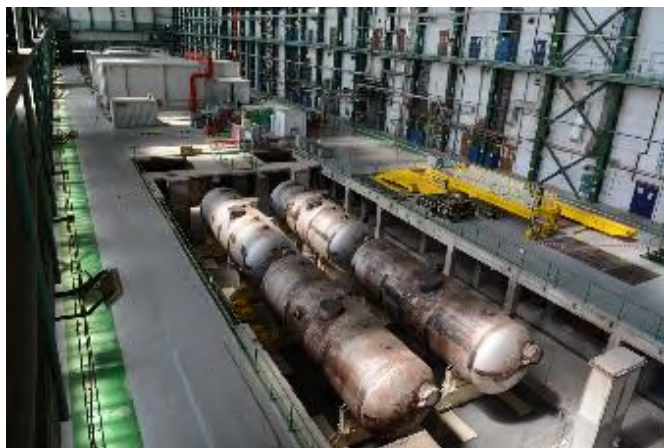
Figur 5: Verkstad och lagring av ånggeneratorer i den tidigare turbinhallen bild JAVYS
