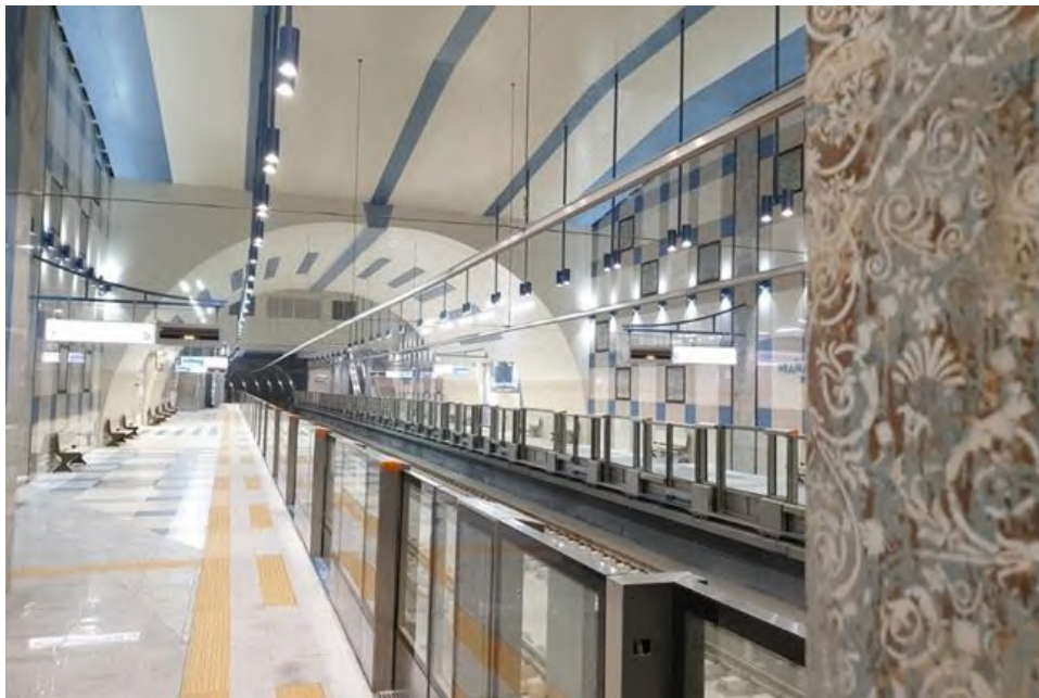
Σταθμός Medical University στη γραμμή 3 του μετρό
